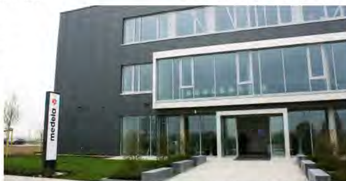
Energetisch und architektonisch gelungen: Der neue Firmensitz der Medela Deutschland in Dietersheim
